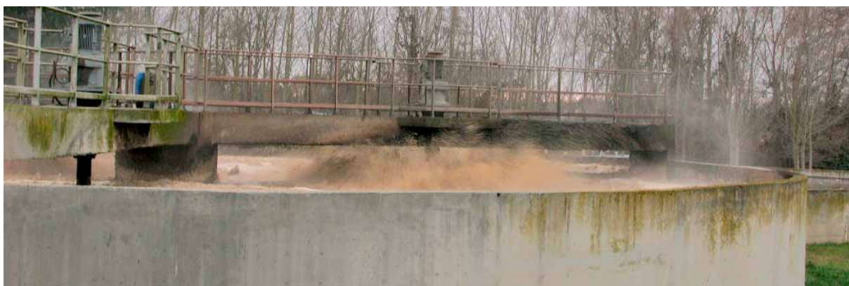
Bac de décantation d'une station d'épuration.
