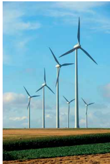
Photographie n° 1. Éoliennes dans le sud de la France (Languedoc).
